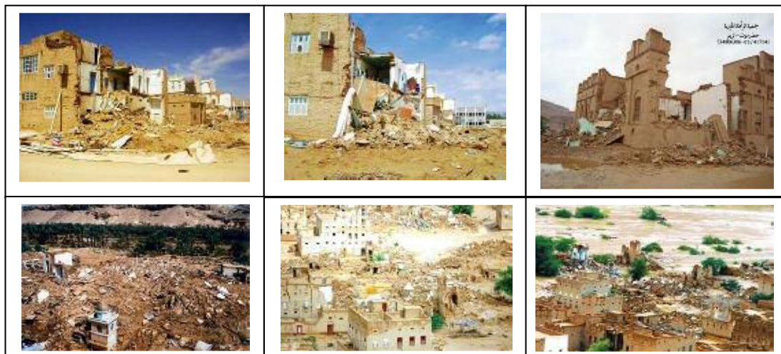
شكل (7): صور فوتوغرافية لبعض المباني المتضررة في وادي حزموت
